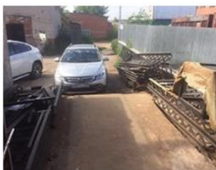
Очередь на монтаж металлических каркасов лестниц
